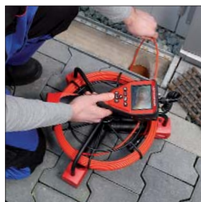
Обследование ливневых труб
