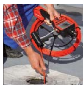
Обследование водостоков
